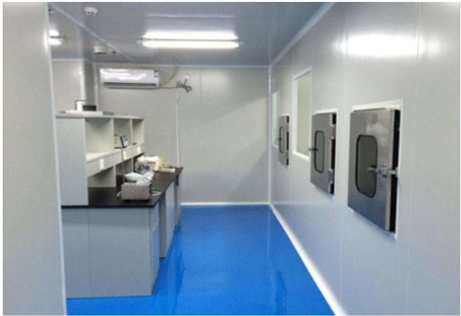
净化车间装修工程吊顶安装注意事项：施工程序合理：先清理卫生后安装，先上部吊装后中间安装，先大设备进场后隔断封闭，先净化安装后工艺安装。净化车间完成安装后进行地面处理，先调整后检测。空调管路安装与工艺管路安装同时进行，净化车间工程与交货空调设备同时进行，洁净系统工程各专业同时试运转、同时调整检测；土建收尾工程与洁净安装部分同时进行。管道吊杆一定要平直、不弯曲。风管吊上后，吊杆螺丝要收紧，使每根吊杆都平均受力。有弯头的风管，吊杆位置一定要在法兰旁边。风管要设置固定支架，出风口一定要吊在机组出风弯头内侧。
